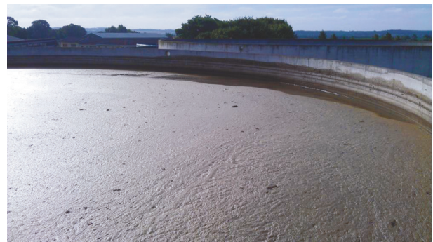
Abbildung 2: Schwimmlichtbildung nach 24 Stunden und Applikation des Additivs Active NS in das 2.800 m 3 Biogasanlagen-Endlager nach einstündiger Volldurchmischung mittels eines zapfwellenbetriebenen Rührwerks für die repräsentative Probennahme
