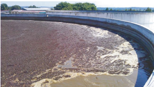
Abbildung 1: Schwimmlichtbildung des 2.800 m 3 Biogasanlagen-Endlagers nach einstündiger Volldurchmischung mittels eines zapfwellenbetriebenen Rührwerks für die repräsentative Probennahme der Kontrolle ohne Additiveinsatz
