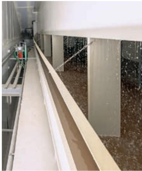
Einsatz eines Abluftwäschers um die ammoniakhaltige Abluft, die aus dem OptiSec Porco kommt, zu reinigen
