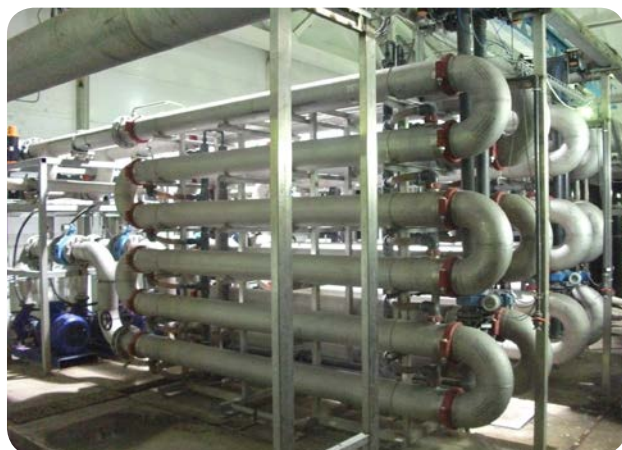
Externe UF-Membranen als Teil des Hochleistungs-MBRs
