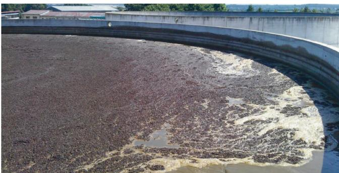
Ohne Active NS: Bildung einer Schwimmschicht im Güllebehälter
