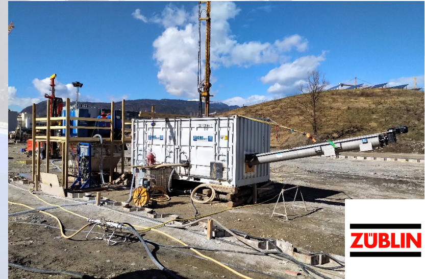
➤ GHT 390_ Baustelle Villach Zentrum 2019 (Züblin)
